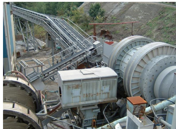
再生骨材の製造設備
