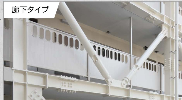
天井の補強と杭工事が必要
