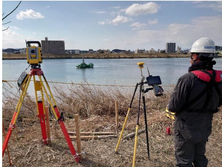
ICT 施工対応の水陸両用ブルドーザ工法
