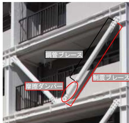
写真1 制震ブレース設置状況
