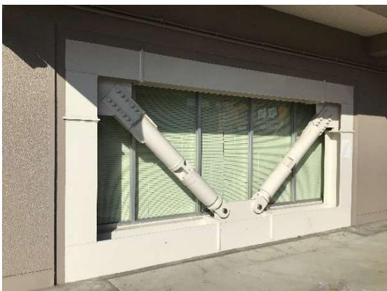
写真5 大容量型制震ブレース
