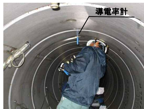
写真1 推進管内における導電率の測定状況
