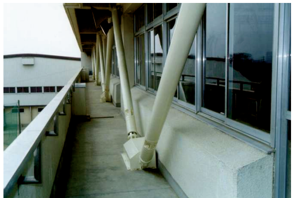
写真2 某公立中学校の補強例
