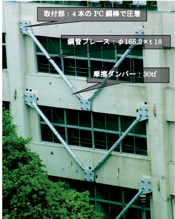
写真1 制震ブレースの取付例
