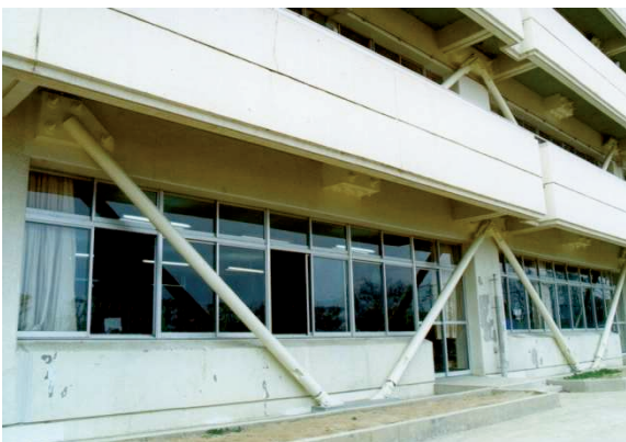
写真2 某公立中学校の補強例
