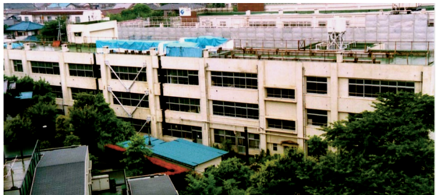
写真5 実験が行われた校舎の全景と実験状況
