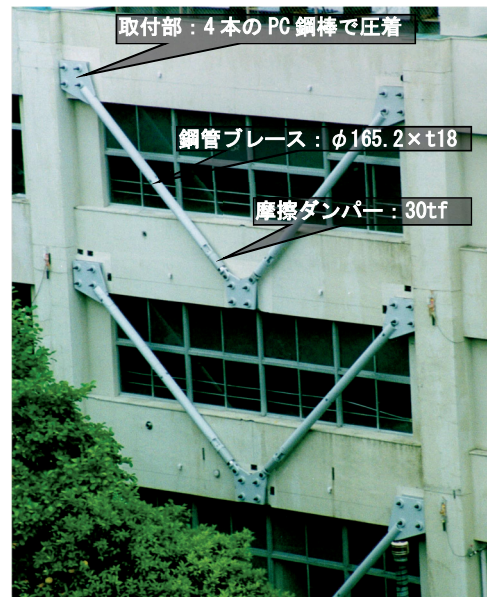
写真1 制震ブレースの取付例
