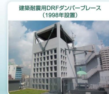
建築耐震用DRFダンパーブレース(1998年設置)
